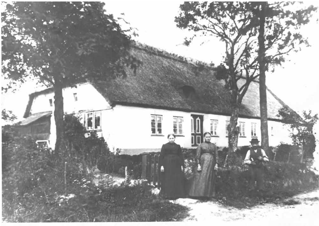
Asserballevej 8a: Pæleværk set fra vest fra gamle vej, som blev flyttet til den anden side af huset i 30erne.
